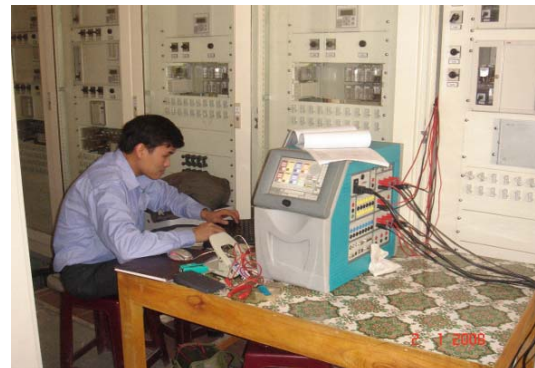
Thí nghiệm hiệu chỉnh hệ thống điều khiển bảo vệ Nhà máy Thủy điện Tuyên Quang 342MW-13,8/220kV
