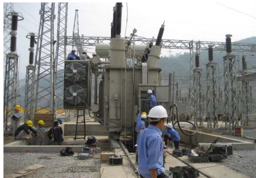
Thí nghiệm hiệu chỉnh Máy biến áp 220/110/35kV-63MVA - Nhà máy Thủy điện Tuyên Quang
