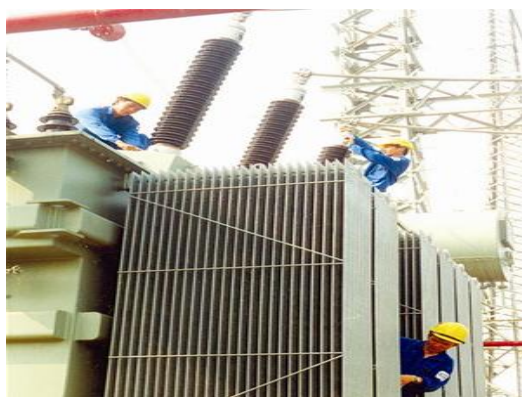
Xây lắp mở rộng tại Trạm biến áp 500/220KV Pleiku
